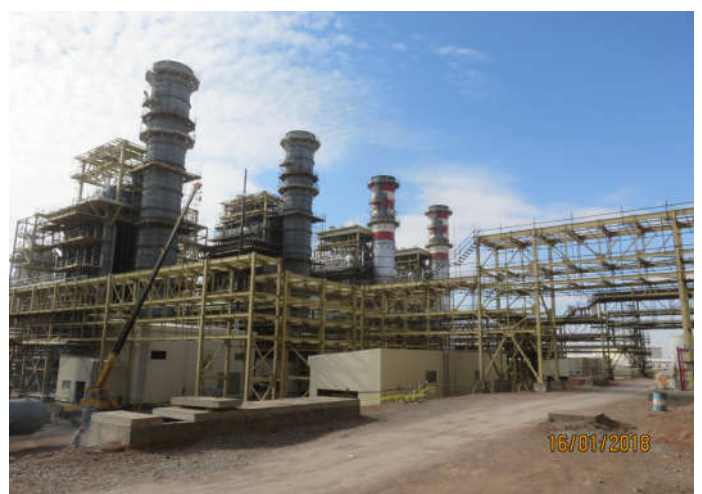
نمای دیگر از ادامه نصب اسکلت فلزی Pipe Rack بویلرهای سه و چهار
