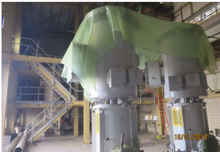
نمایی از ادامه نصب پمپ های CEP واحد دو
