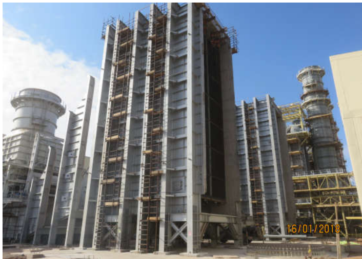
نمایی از شروع و ادامه نصب هارپ در بویلر شش
