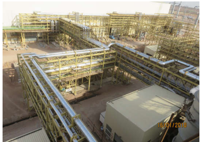
نمایی از ادامه عایقکاری خطوط External Piping بویلرهای یک و دو
