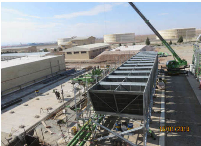
نمایی از ادامه عملیات Piping و شروع نصب V_Unit های سیستم ACS واحد دو
