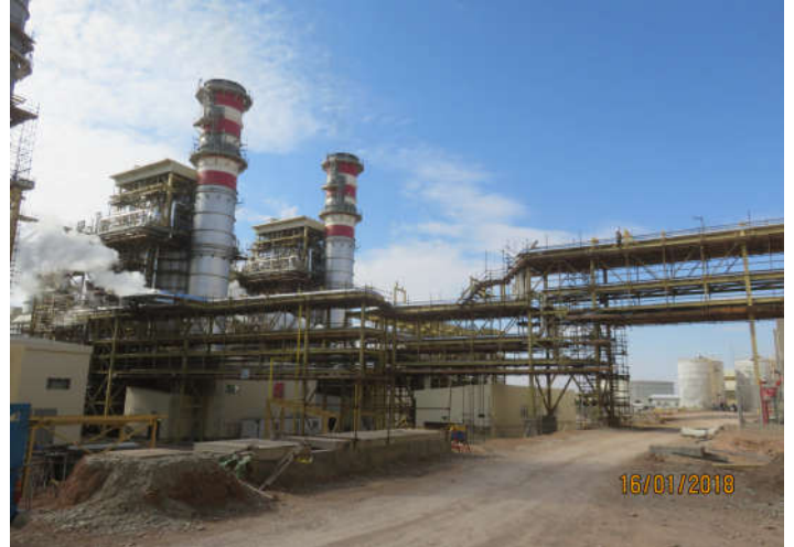
نمایی از اجرای External Piping بویلرهای یک و دو
