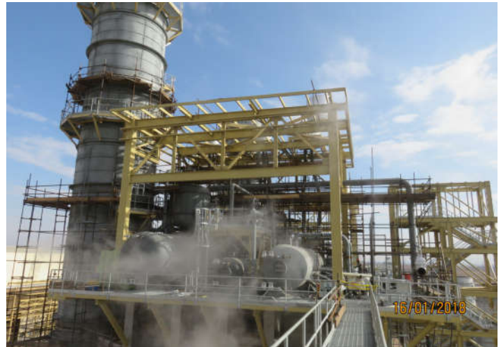
نمایی از ادامه عملیات نصب و اجرای Piping بویلر شماره سه
