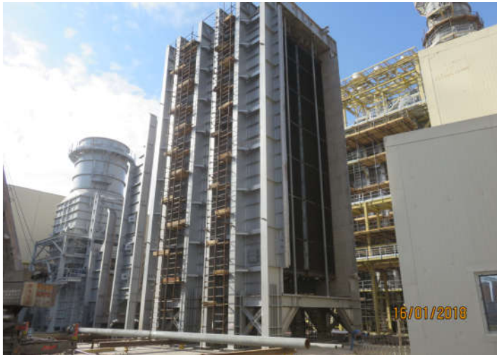
نمایی از تکمیل نصب هارپ و شروع اجرای Piping بویلر پنج
