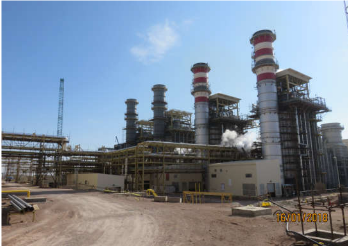
نمایی از ادامه عملیات ساخت بویلرهای یک الی چهار
