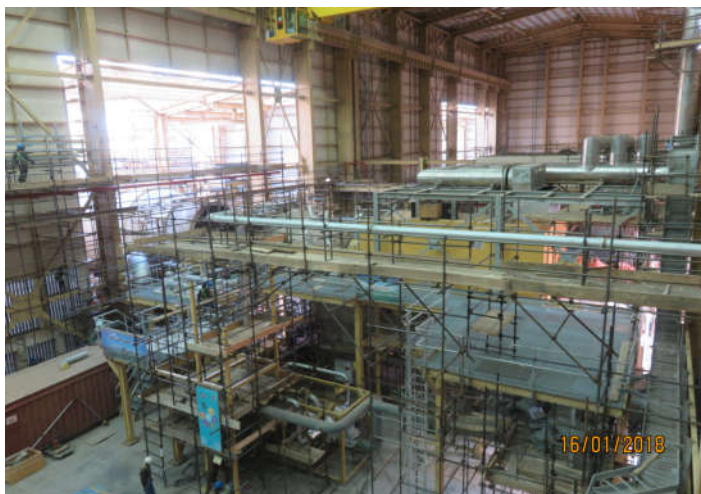
نمایی از عملیات نصب تجهیزات و اجرای Piping در سالن توربین واحد دو
