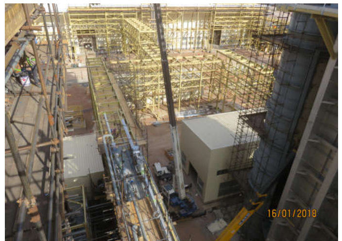
نمایی از ادامه نصب اسکلت فلزی Pipe Rack بویلرهای سه و چهار
