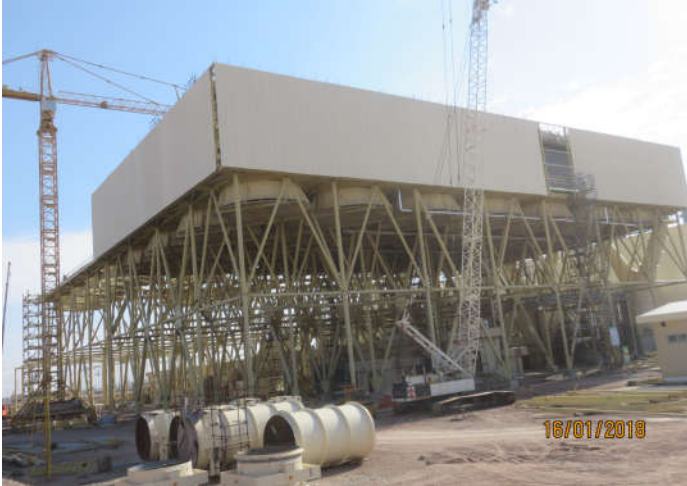
نمایی از شروع و ادامه نصب ورق های Win Wall سازه ACC واحد یک
