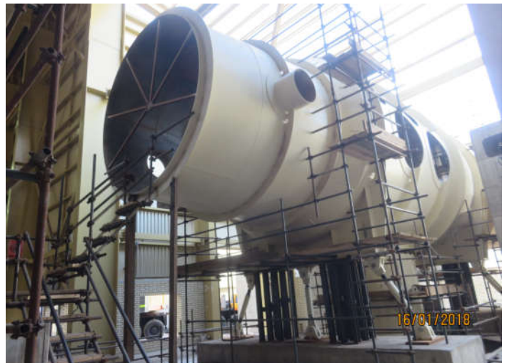
نمایی از ادامه نصب داکت های Main steam واحد سه
