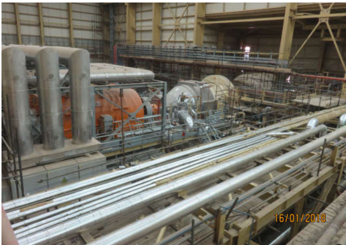
نمایی از ادامه اجرای عایقکاری باقیمانده در سالن توربین بخار واحد یک
