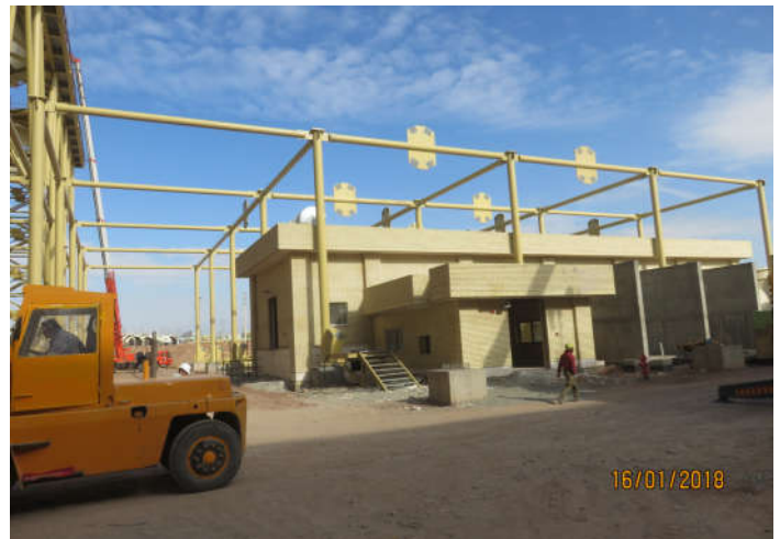
نمایی از ادامه عملیات نصب اسکلت فلزی سازی ACC واحد سه
