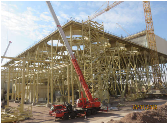
نمایی از شروع و ادامه نصب Fan Bell و اسکلت فلزی راه پله سازه ACC واحد دوم
